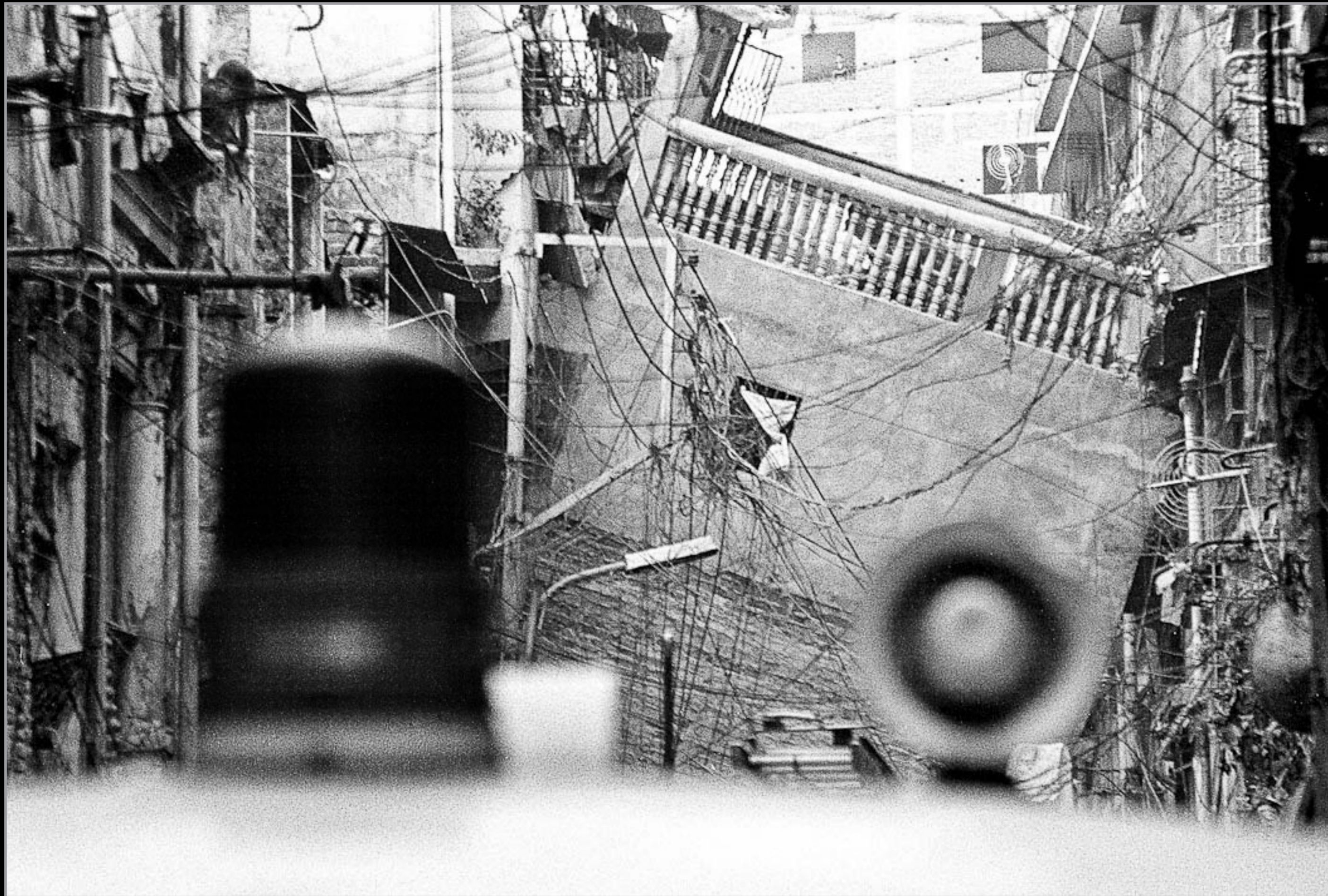
Ein Krankenwagen steht vor den Überresten des eingestürzten Gebäudes in Shakari Bazar in der bangladeschischen Hauptstadt Dhaka. Die oberen drei Geschosse, die mehrere Jahrzehnte nach dem Originalbau errichtet wurden, zermalmten bei dem Einsturz die Altbaumasse und rutschten in einem Stück auf die Straße.
