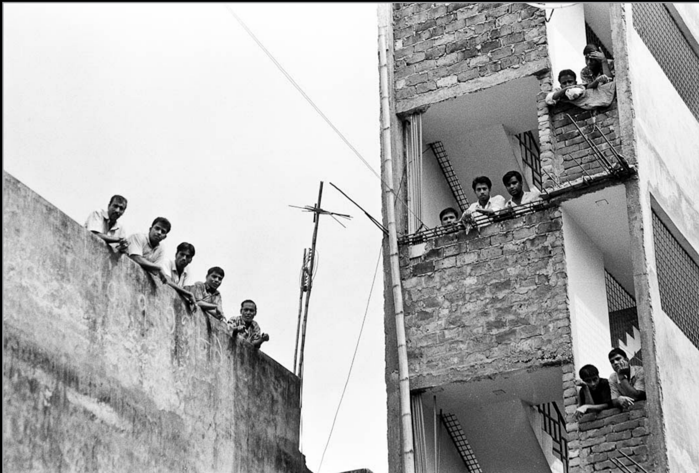
Trotz Warnungen, dass die benachbarten Gebäude ebenfalls vom Einsturz bedroht sind, beobachten Anwohner von ihren Häusern aus die Rettungsarbeiten in den Trümmern des kollabierten Wohnhauses.
