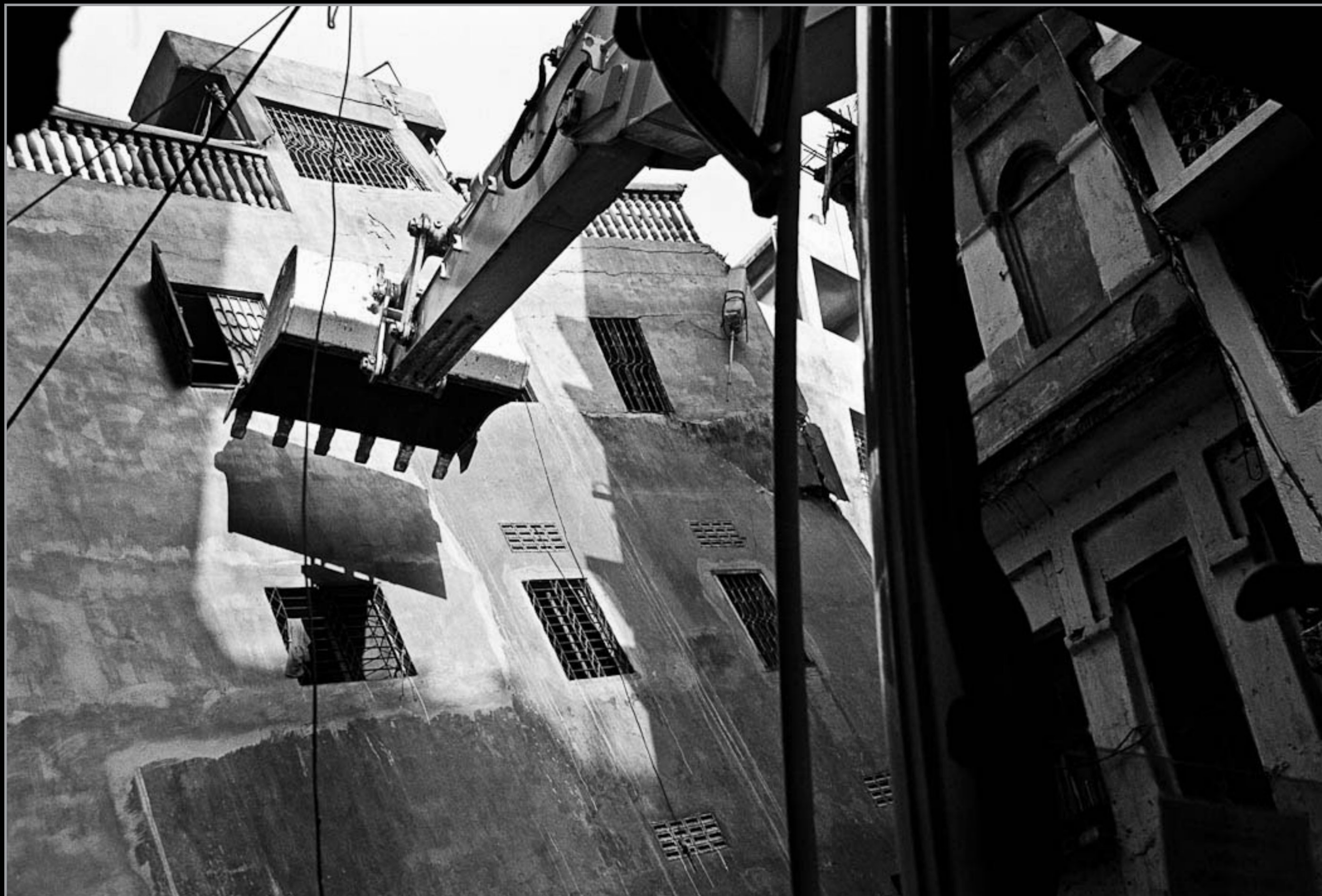
Ein Bagger beginnt mit den Abrissarbeiten an den oberen drei Stockwerken des kollabierten Gebäudes, die den Einsturz in einem Stück überstanden hatten und auf die Strasse gerutscht waren. Der Gebäudeteil versperrte den Weg für Einsatzfahrzeuge und stellte eine unmittelbare Gefahr für die Rettungskräfte dar.
